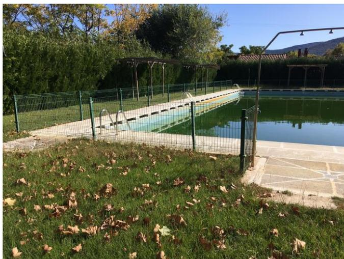
Al eliminar este rebosadero de la filtración de la piscina, se realizarán la sustitución de las albardillas de la misma, visto el lamentable estado de conservación de las actuales ya que presentan fisuraciones, roturas y desconchones que si sumamos a las obras de actuación en los rebosaderos aconsejan su sustitucion.
